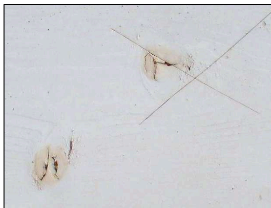
Abb. 2.7: Verfärbungen des Beschichtungssystems durch Holzinhaltsstoffe im Astbereich
