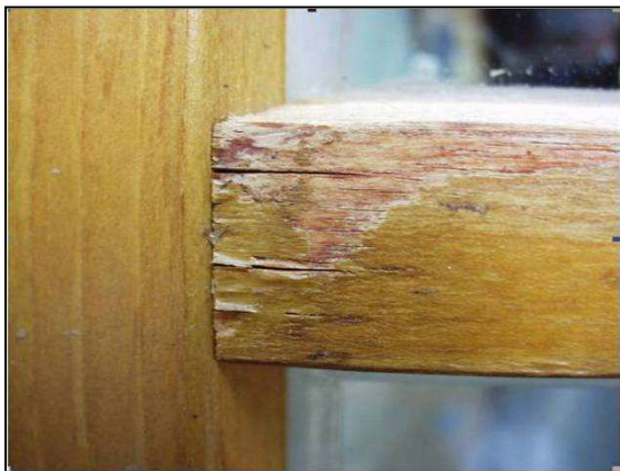
Abb. 4.5: Schäden im Fugenbereich
