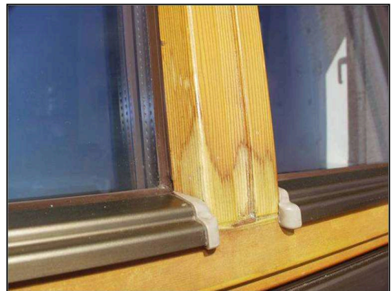
Abb. 4.6: Schäden im Fugenbereich
